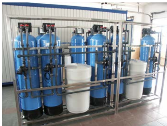
Мобильный (левый) и встроенный (правый) блок очистки воды
